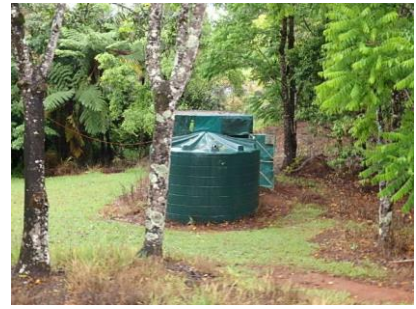
【ロッジの貯水タンク】
